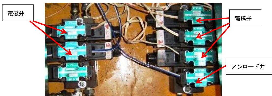
図 29 電磁弁
