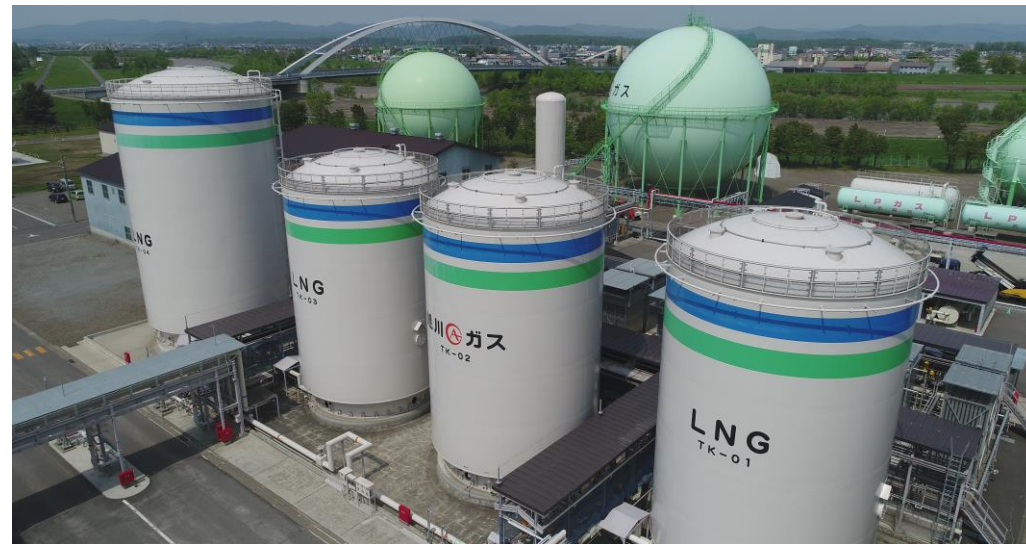
旭川ガス永山工場前全景
