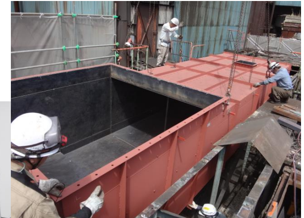
煙道更新工事
