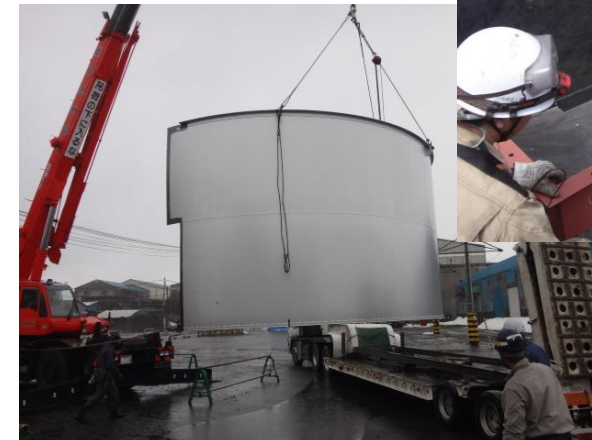
タンク設置工事
